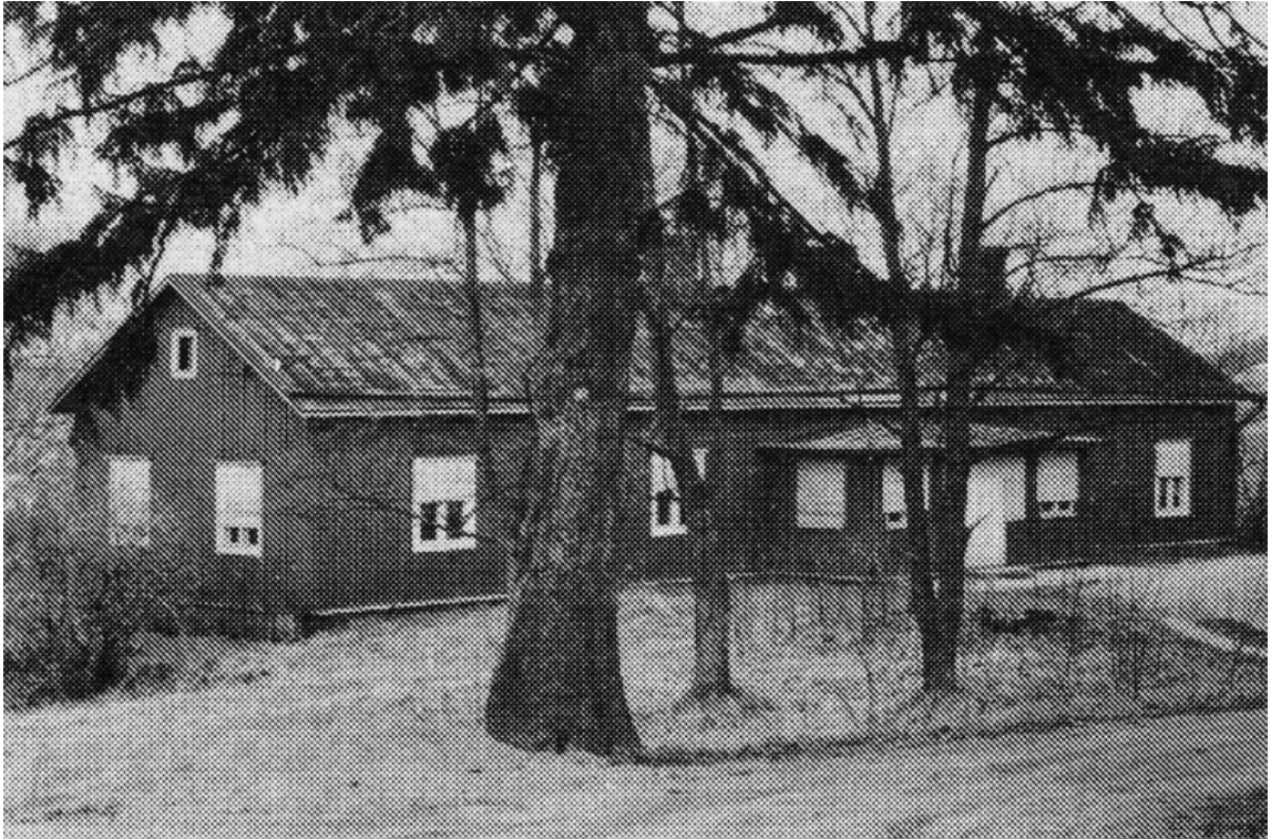
Kuva Solakallion päärakennuksesta vuodelta 1968, jolloin laudoitus peitti osan ikkunoista.
